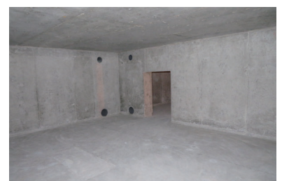
雨水貯留槽の内部の様子
